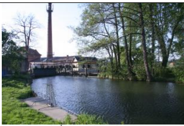
72 - Čermná n. Orlicí – nadjezí MVE
