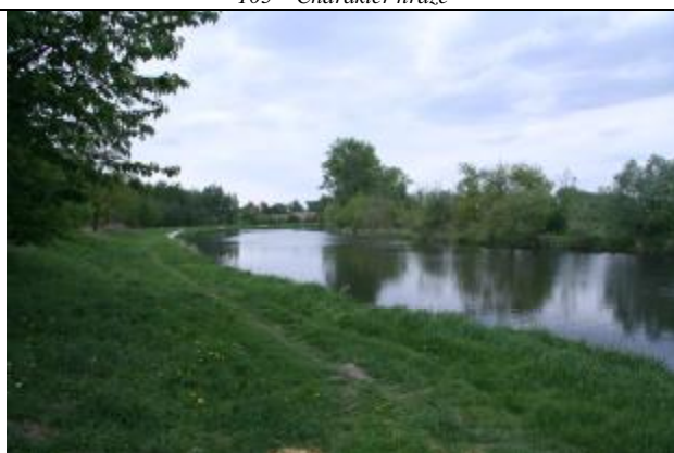
1022 Albrechtice n.Orlicí – prostor levobřežní hráze
